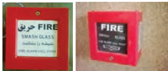
شکل ۱-۲۱ دو نمونه شستی اعلام حریق شیشه‌ای
