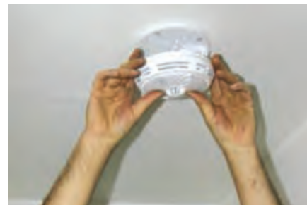
شکل ۱-۱۵ قرار دادن یک نوع آشکارساز روی پایه
